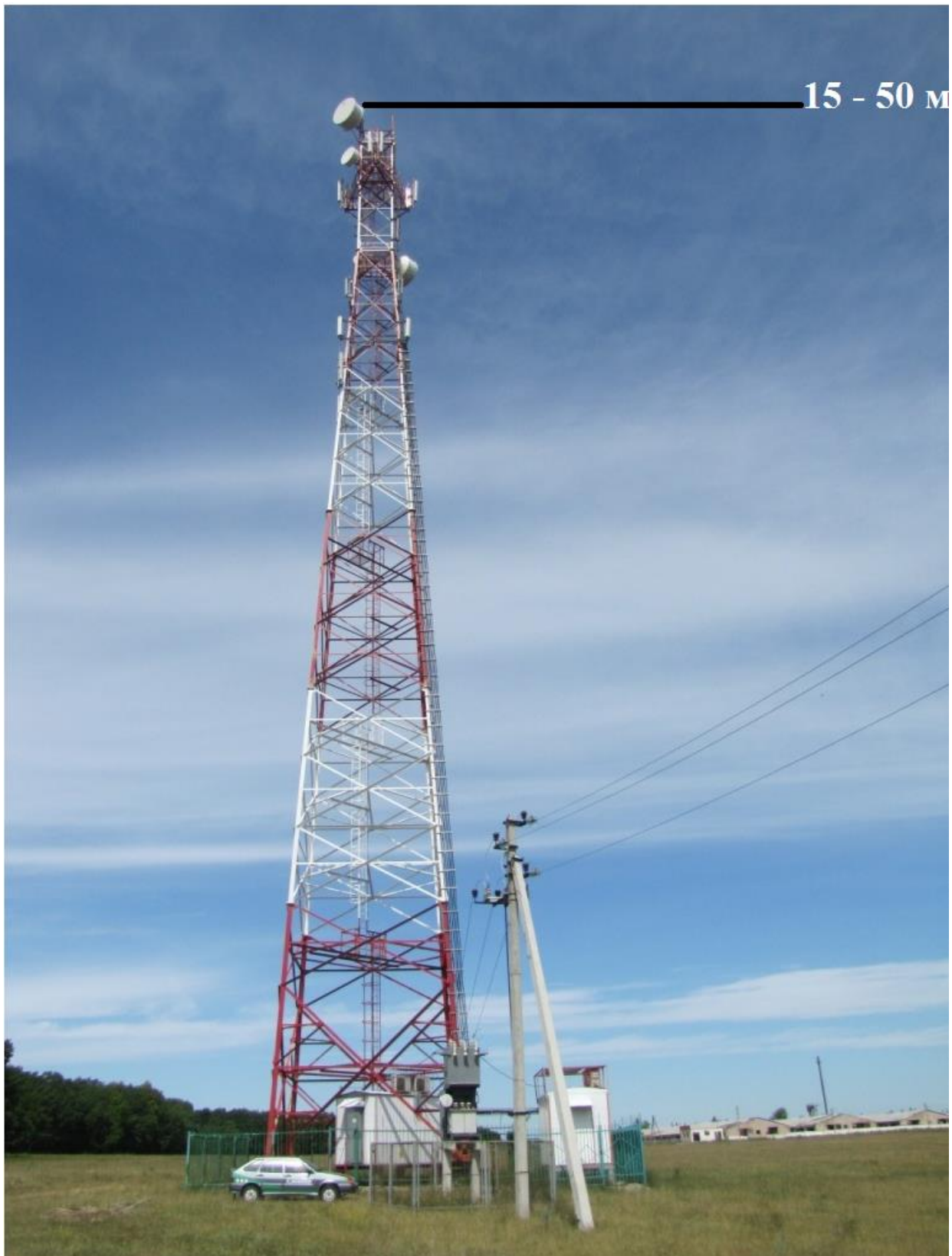
Рисунок 3.3. Приклад постановки базової станції
