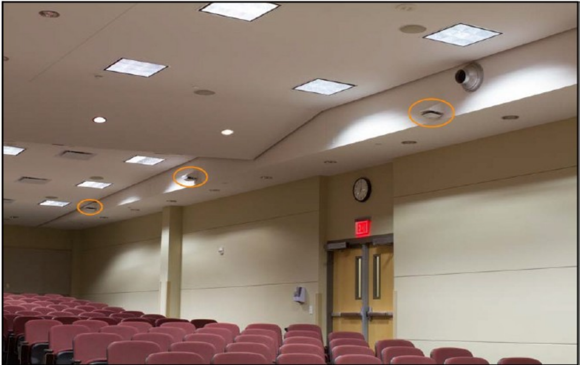
Рисунок 2.2. Точка доступу, що розміщена на високому рівні в Лекційному залі в університеті Айови
