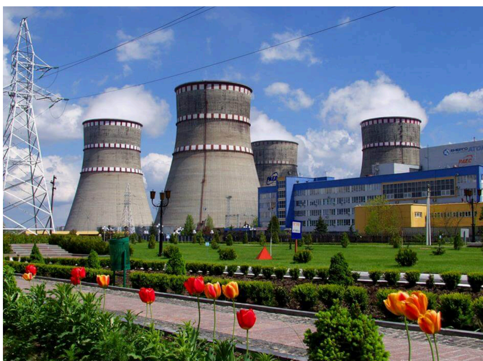
Рис. 2.4. Енергоблоки Рівненської атомної електростанції
