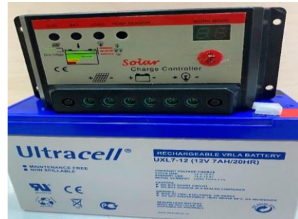
Рис.1.20 Свинцево-кислотна батарея з сонячним контролером
