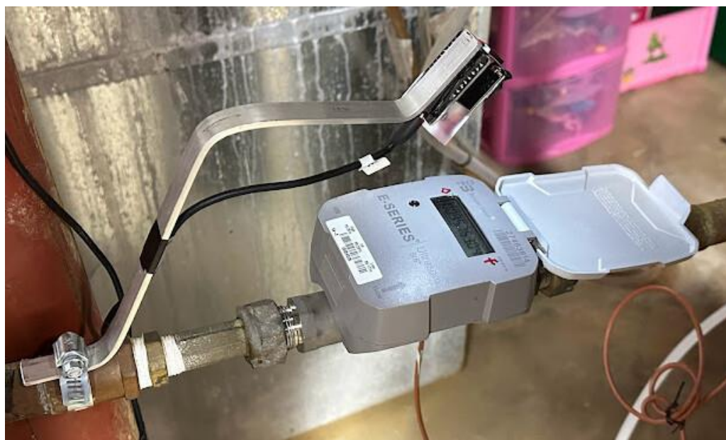
рис.4 механічний лічильник зі встановленою камерою
